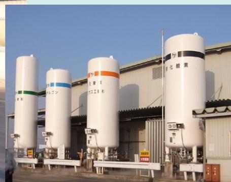
トレーラが搬入した高圧ガスを保管する大型タンク
